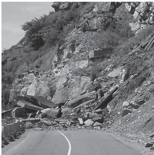
Рис. 3.7. Обвал на дороге
