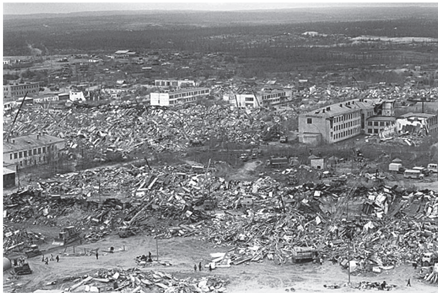
Рис. 3.1. Последствия землетрясения в Нефтегорске
