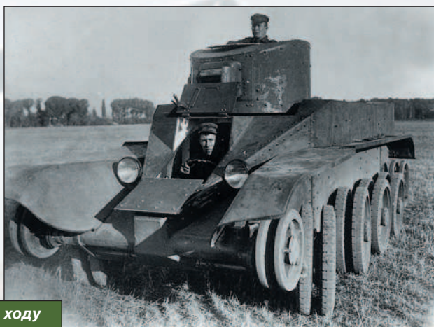
Опытный колесно-гусеничный танк БТ-5-ИС с наклонной бортовой броней
