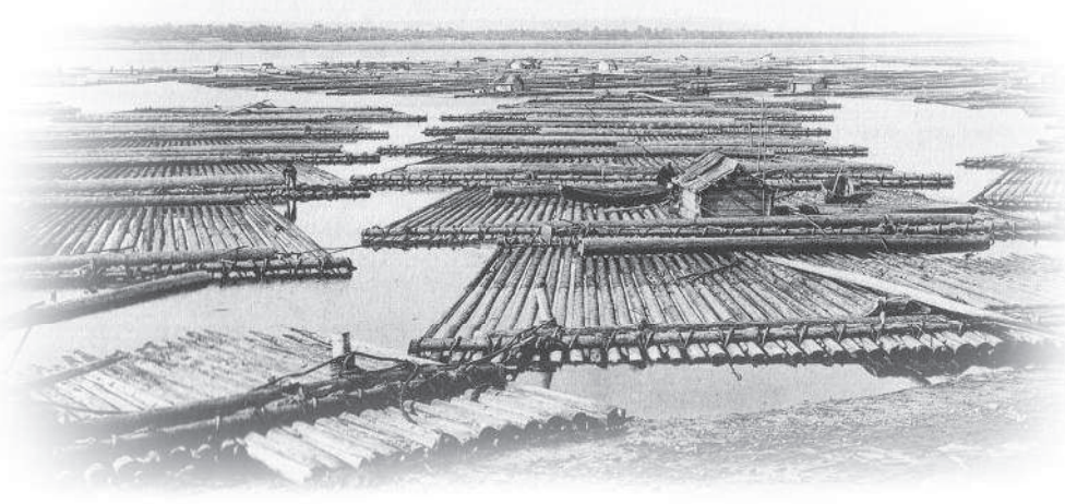
Плоты на Волге. XIX в. На дореволюционной открытке наглядно показана конструкция плотов, технология строительства которых и техника передвижения на них по русским рекам за два тысячелетия практически не изменились
