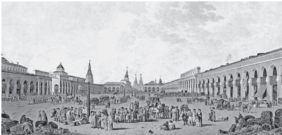
Верхние торговые ряды после перестройки по проекту Дж. Кваренги.
